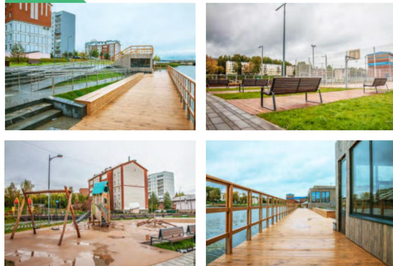
В рамках проекта выполнены грунтовые работы, берегоукрепление, инженерные работы, устроено покрытие из брусчатки с бордюрами, высажены деревья и кустарники, устроен спуск к воде, установлены малые архитектурные формы. Территория освещена
