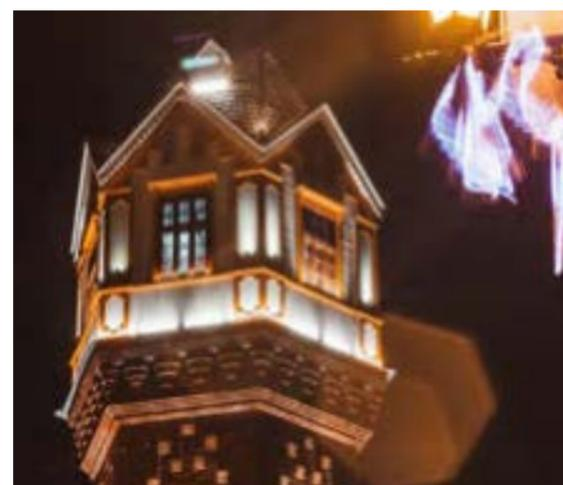
Была выполнена подводка коммуникаций, реставрация цоколя, кирпичной кладки фасада и интерьеров, дверных и оконных заполнений, воссоздание и обшивка каркасных стен надстраиваемого яруса, реставрация и устройство декоративной подсветки здания. Отреставрированная водонапорная башня выполняет важную градостроительную функцию, являясь доминантой центральной части города, где сохранился ряд исторических объектов, формирующих ее облик
